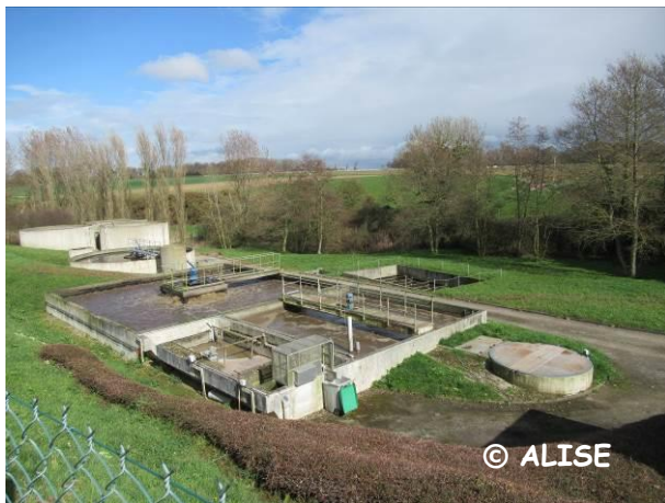
Photo 9 : Station d'épuration des Loges
